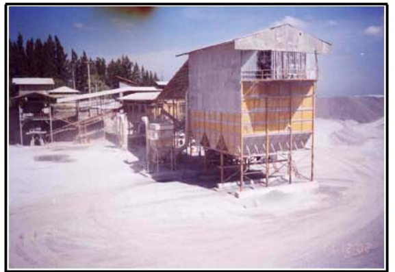
- โรงโม่ระบบปิดคลุมและระบบกำจัดฝุ่นแบบ Bag Filter
